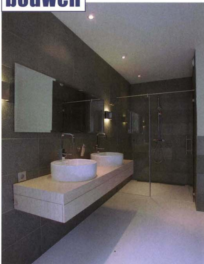
In alle vertrekken, ook in de badkamer, is een milieuvriendelijke en oplosmiddelrijke gietvloer toegepast van twee componenten polyurethaanhars.
