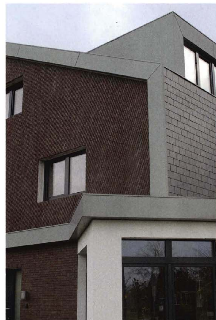
Leuk ontwerpdetail: de stenen van de gevel zijn haaks op de bovenste daklijst aangebracht.
