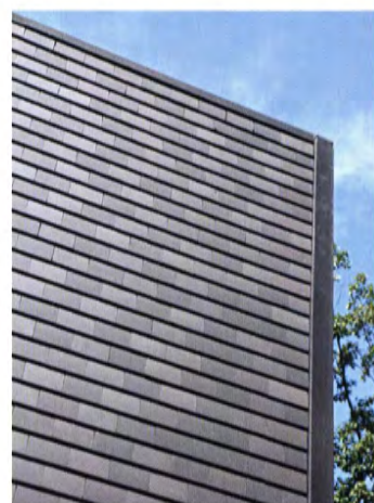
De leien bedekking van het dak loopt door in de zijgevel.
