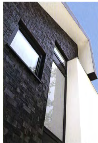
Voegloos metselwerk voor de voorgevel in zwarte 'ClickBrick' bakstenen.
